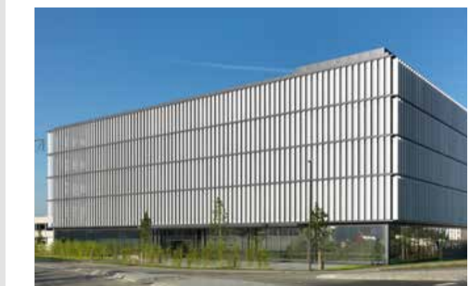
ABB UNTEN: GEBÄUDEHÜLLE, VOLLFLÄCHIG MIT SOLARFIN VERSCHATTUNGSELEMENTEN UMMANTELT
