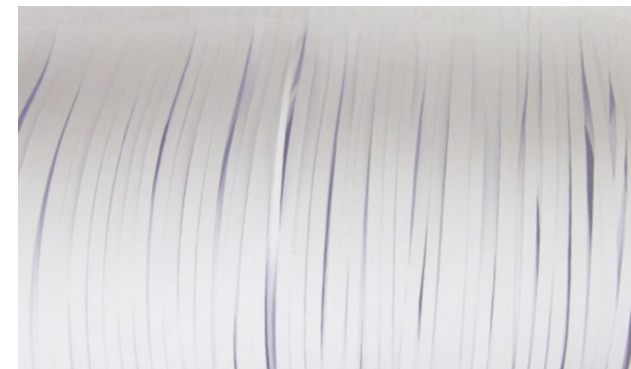
ABB. OBEN, RECHTS, UNTEN: MEHRLAGIGE, SCHMALE UND FLEXIBLE LAMELLEN ERGEBEN EIN VIELSEITIGES SPIEL AUS LICHT UND SCHATTEN. JE NACH KRÜMMUNG DER LAMELLEN UND SONNENSTAND, VERÄNDERN SICH DIE EINFALLENDE LICHTSTÄRKE UND DAS SCHATTENBILD. DURCH DIE MEHRLAGIGKEIT DER SCHMALEN LAMELLEN ERGEBEN SICH SUBTILE NUANCEN ZWISCHEN TOTALER DURCHSICHT, ÜBER DIFFUSES LICHT BIS ZUR VÖLLIGEN VERSCHATTUNG DER FLÄCHE.
