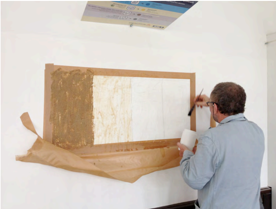
Bereich zwischen Speiseausgabe und Frühstücksraum Gegenüber dem Garteneingang
