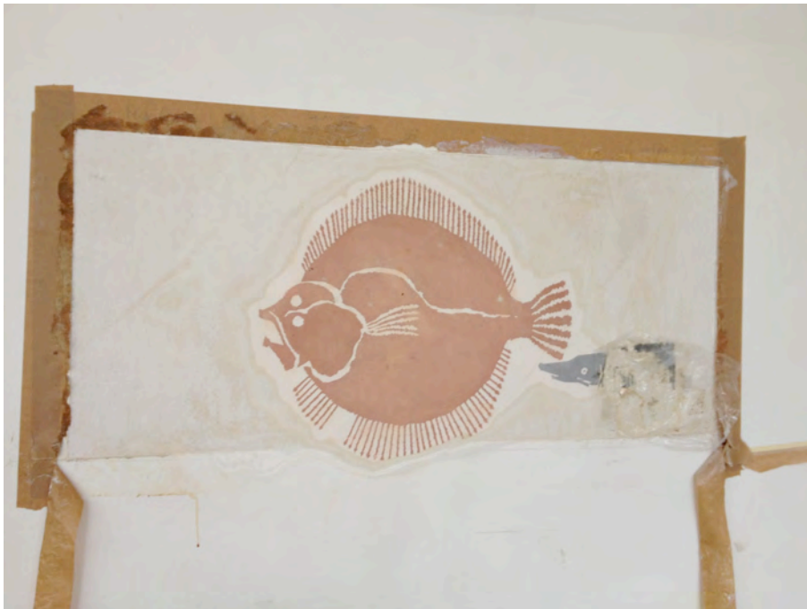
Freilegen und schleifen der Wandfläche
