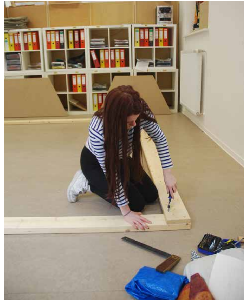
Johanna Reschke dreht die ersten Schrauben ein, nachdem sie mit dem Metallwinkel ausgemessen hat, wie die Latten liegen müssen damit der Rahmen rechteckig wird.
